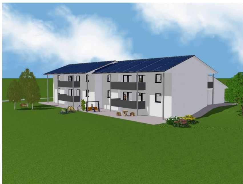
Vue de l'arrière du bâtiment (sud-est)
